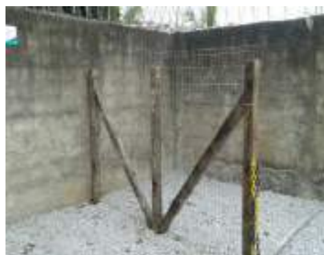
BAIAS MONTADAS UTILIZANDO CRUZETAS E TELAS GALVANIZADAS
