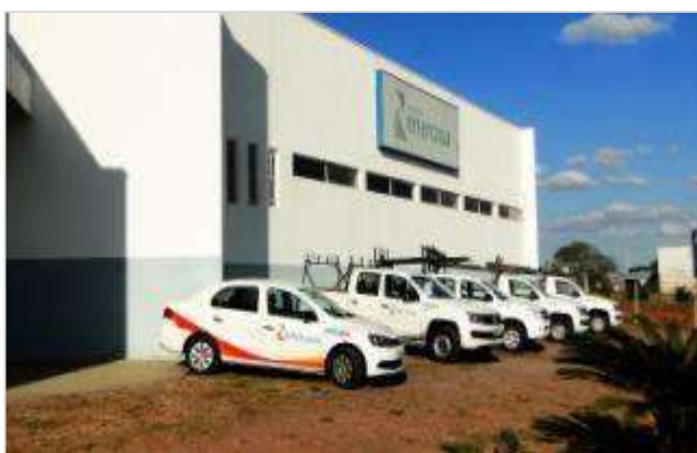
CONSERVAÇÃO DA FACHADA
