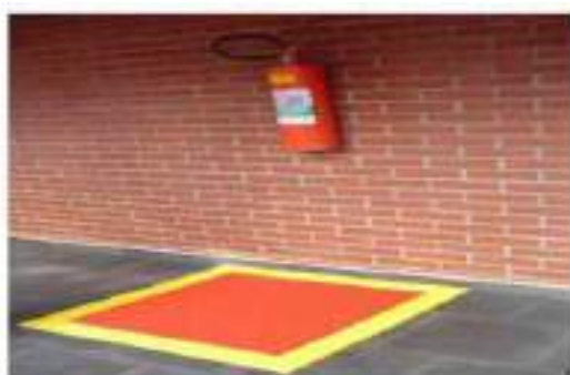
DEMARCAÇÃO PARA EXTINTORES
