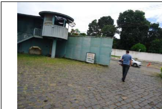
Foto 01: Vista da entrada da portaria
