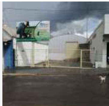
Detalhe da frente do Imóvel avaliando - Galpão Comercial da empresa Brava Agronegócios LTDA, matrícula nº 8.716, Lote 09, Quadra 108, Setor Norte, Rua Rondônia, município de Cristalina-GO.
