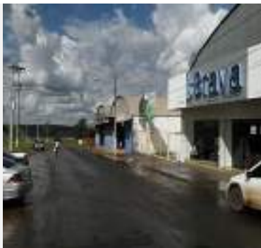
Detalhe da Rua Rondônia, Imóvel avaliando - Galpão Comercial da empresa Brava Agronegócios LTDA, matrícula nº 8.716, Lote 09, Quadra 108, Setor Norte, município de Cristalina-GO.
