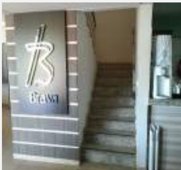
Detalhe da escadaria em alvenaria no acesso ao piso superior, prédio comercial Brava Agronegócios, município de Cristalina-GO.
