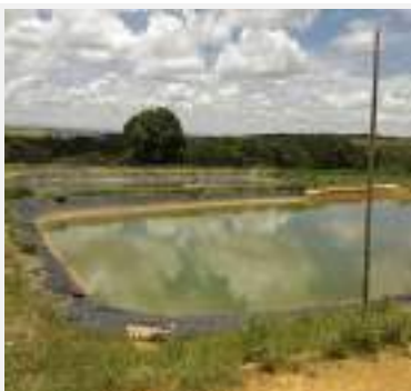
Detalhe dos tanques reservatórios utilizados p/ alimentação hídrica do sistema de irrigação do imóvel avaliando, (Matrícula nº 25.572 - Faz. Realeza), (Coordenadas: 16°45'48.38"S | 47°33'18.95"O), município de Cristalina-GO.
