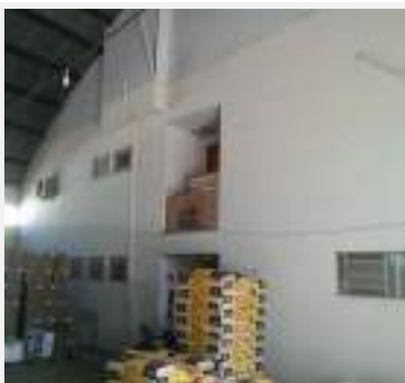
Visão geral da divisa do Galpão p/ depósito de produtos, Brava Agronegócios, município de Cristalina-GO.
