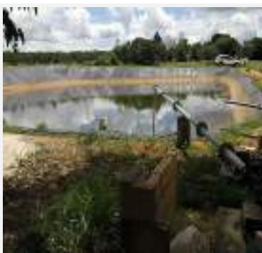
Detalhe dos tanques reservatório principal utilizado p/ alimentação hídrica do sistema de irrigação do imóvel avaliando, (Matrícula nº 25.572 - Faz. Realeza), (Coordenadas: 16°45'49.50"S | 47°33'17.95"O), município de Cristalina-GO.
