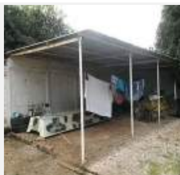
Detalhe do interior do Imóvel avaliando (Garagem coberta p/ depósito de materiais) matrícula nº 10.351, Lote 15, Quadra 108, Rua Niterói, Setor Norte, município de Cristalina-GO.
