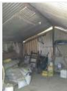
Detalhe da benfeitoria edificada (Depósito de Ferramentas) do imóvel avaliando, (Matrícula nº 25.572 - Faz. Realeza), (Coordenadas: 16°45'47.15"S | 47°33'18.80"O), município de Cristalina-GO.
