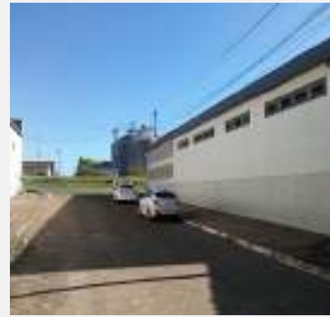
Detalhe da lateral do prédio comercial, vista pela Rua Rio Grande do Sul, Setor Norte, município de Cristalina-GO.
