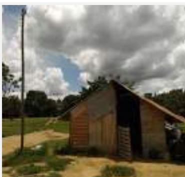
Detalhe da benfeitoria edificada (Depósito de Ferramentas) do imóvel avaliando, (Matrícula nº 25.572 - Faz. Realeza), (Coordenadas: 16°45'47.15"S | 47°33'18.80"O), município de Cristalina-GO.
