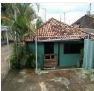
Detalhe do interior do Imóvel avaliando (Primeira construção, c/ 101,63m 2 ) matrícula nº 10.351, Lote 15, Quadra 108, Rua Niterói, Setor Norte, município de Cristalina-GO.
