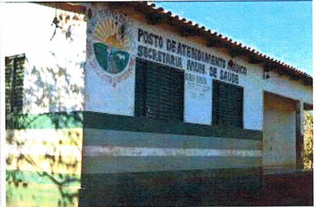
Prédio do posto de saúde
