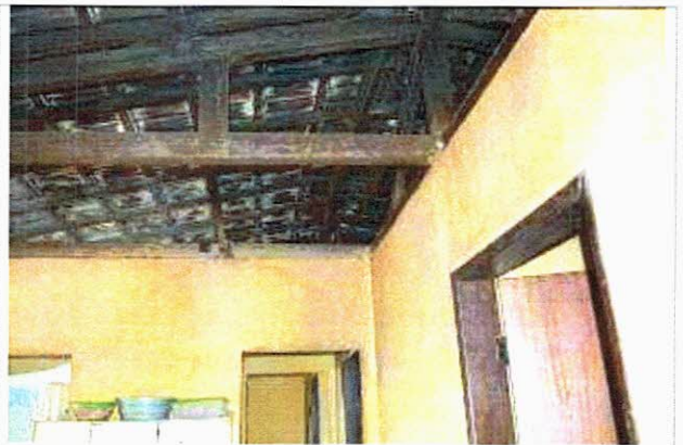
Interior da casa sede
